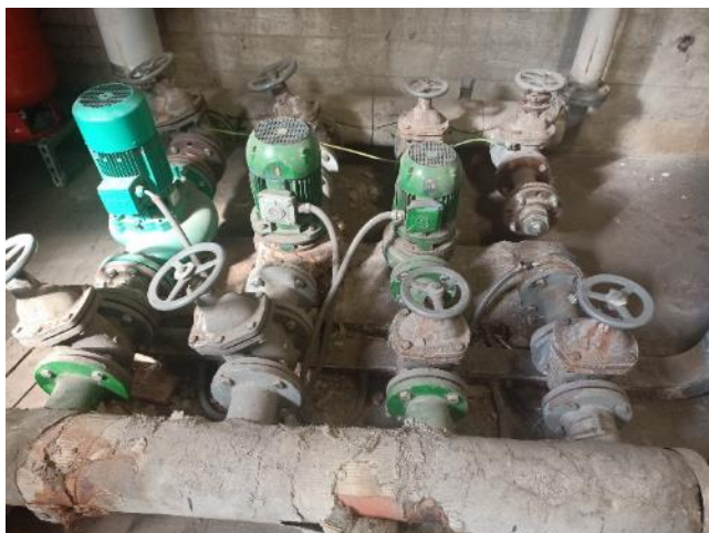
Foto 7 – collettore batterie di scambio UTA
