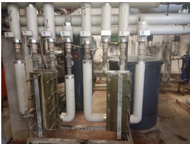
Foto 8 – scambiatori per produzione ACS
