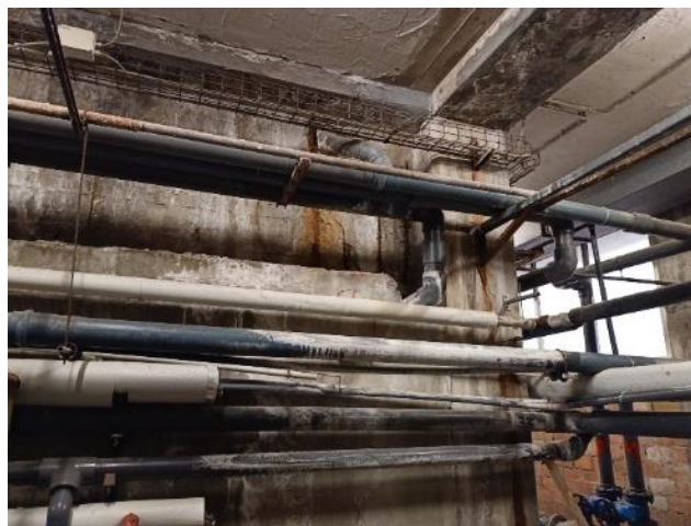
Foto 14 – tubazioni di immissione e scarico
