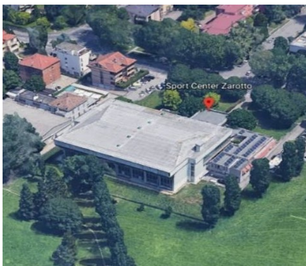
Foto 35 - Vista impianto natatorio
