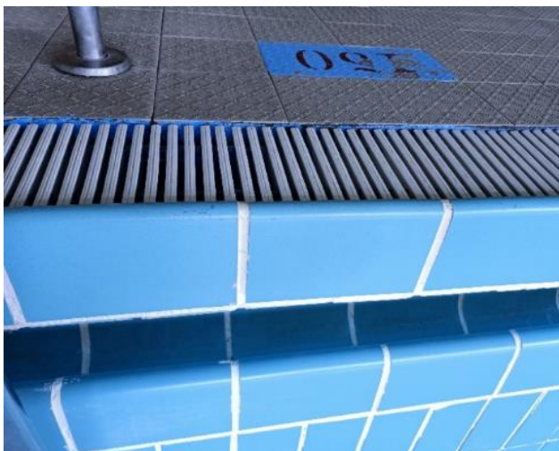
Foto 25 – bordo sfioro superiore ed inferiore vasca grande
