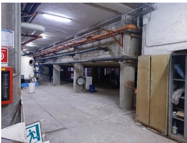
Foto 17 – disposizione vasca "grande" su pilastature
