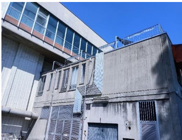
Foto 1 – esterno locale centrale
