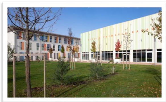
Efficientamento energetico delle scuole
