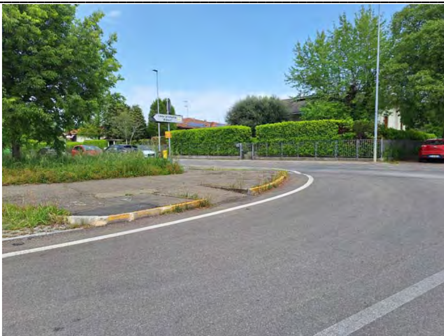
13 – PUNTO DI ARRIVO FUTURA PISTA CICLABILE - INCROCIO STRADA ALBERI – VIA MARTINELLA
