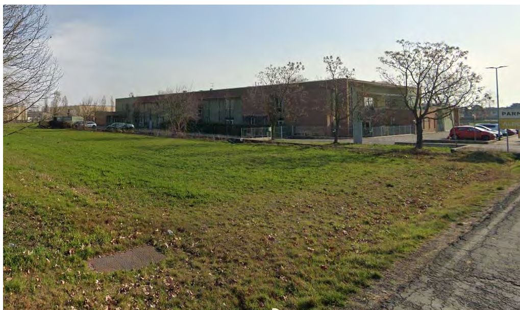
2 - PARTICOLARE CONFINE EST CI COMPARTO CON CASA DI RIPOSO
